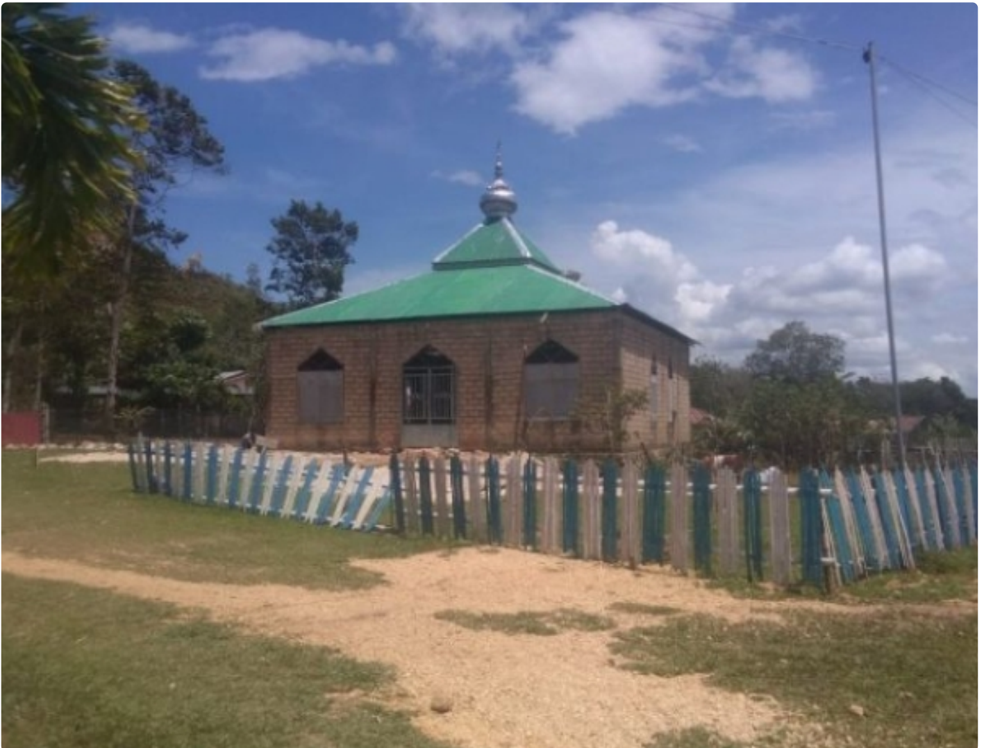
Masjid SMK 9 Pangkep Desa Lanne Kecamatan Tondong Tallasa Masih Butuh Biaya Pembangunan
